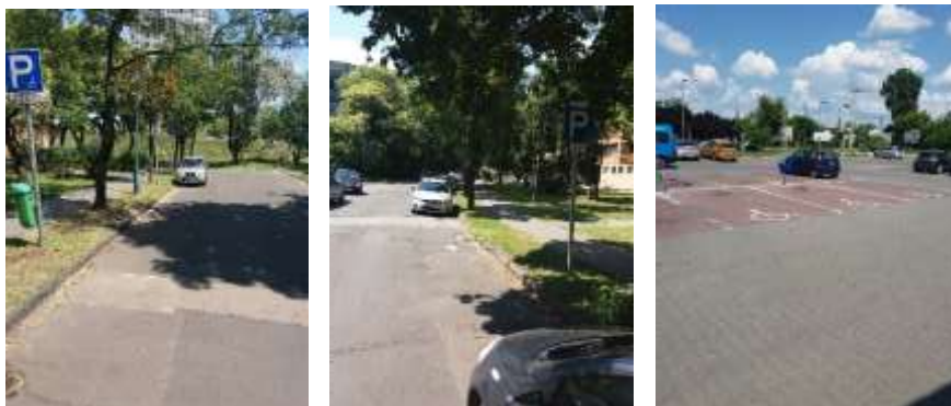
10. ábra: 2018-ban az útburkolati jelek minősége a 2011-es jelminőségnél is rosszabb úgy a hátsó dupla, mint immár az első magányos rokkantparkoló esetén (balra és középen) – ahol az árnyék esetleges jelenléte még tovább rontja az önzetű jármű képfeldolgozási potenciálját / Egy ideális parkolójelölés (eltérő szín, hiánytalan felfestés, tábla) 2018-ból jobbra (forrás: saját fotók)
